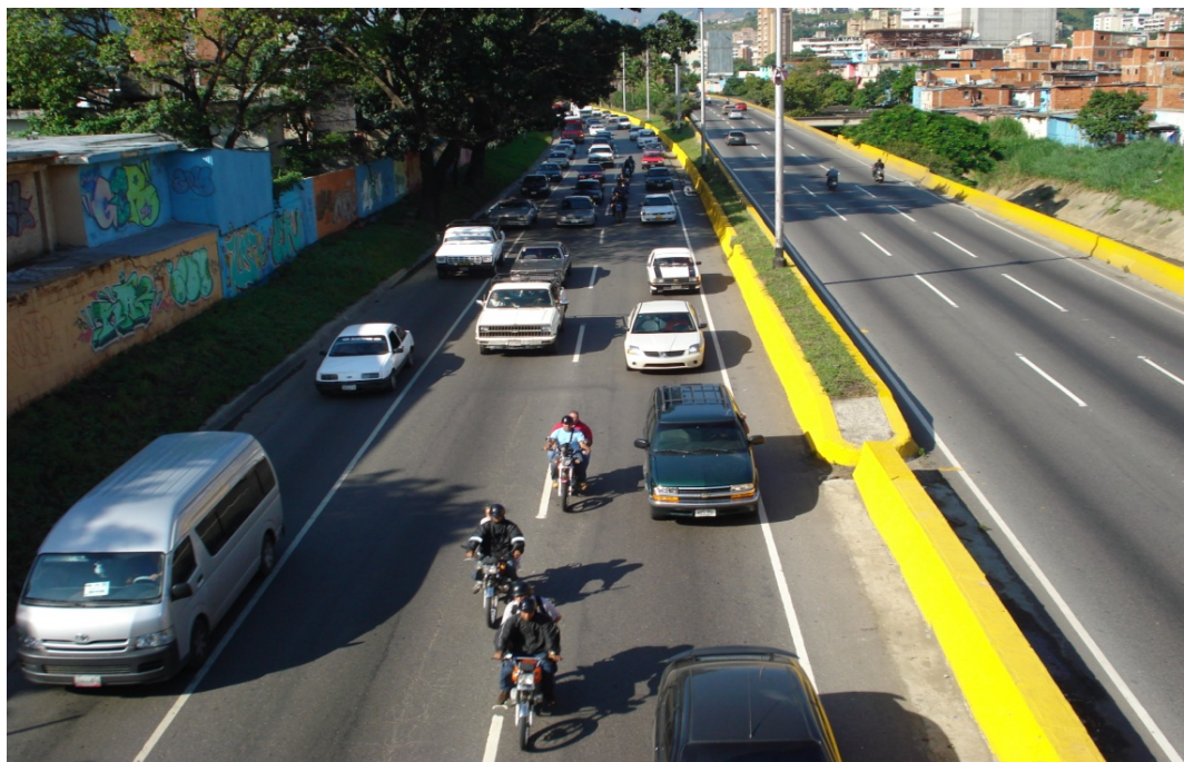
Anexo F-1 Circulación Paralela y Efecto Invasión de Canal. Tramo Puente Los Leones – Distribuidor La Araña
