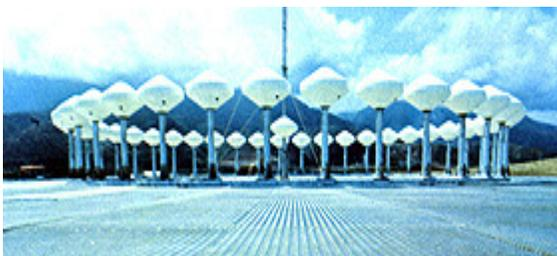
**1976** Entran a operar modernas radio-ayudas como son un radiofaro omnidireccional de muy alta frecuencia–VOR-, el sistema de aterrizaje por instrumento ILS y sistema de medidor de distancias para las aeronaves DME. (foto del VOR)
