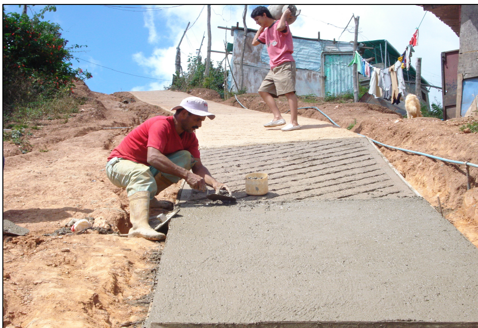
Foto D: Construcción de la rampa por parte de los integrantes de la comunidad La Estrella- La Vega
