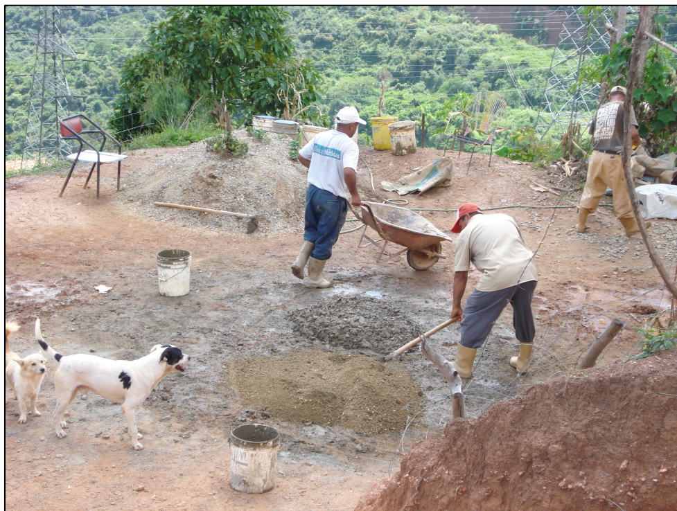
Foto E: Mezcla de materiales para construir la rampa, por los habitantes de la comunidad La Estrella- La Vega.
