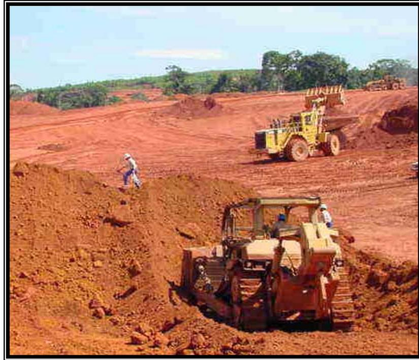
Figura 15 Toma de muestra en corte con tractor
