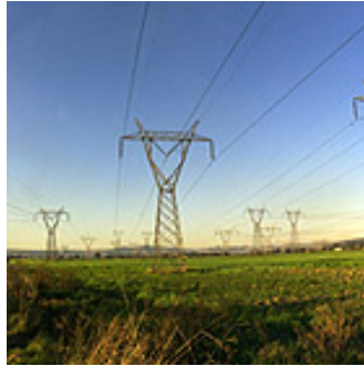
Figura 7. Líneas de alimentación
