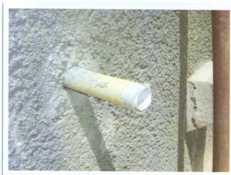
Anexo N° 15.2 Imagen representativa de un dren en el cual se observa la tela de geotextil permeable.
