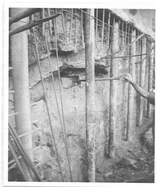
Anexo N° 7.2 Imagen representativa de sobre-volumen en el trasdós de una pantalla. Además se observa que el refuerzo es una combinación entre cabillas y tuberías de acero.
