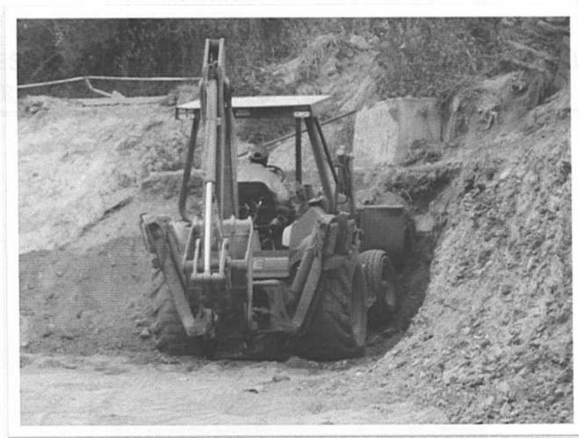
Anexo N° 4.5 Imagen representativa del reperfilamiento del talud a máquina.
