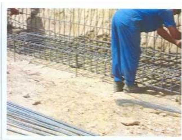
Anexo N° 16.1 Imagen representativa del proceso de armado del refuerzo de la zapata.
