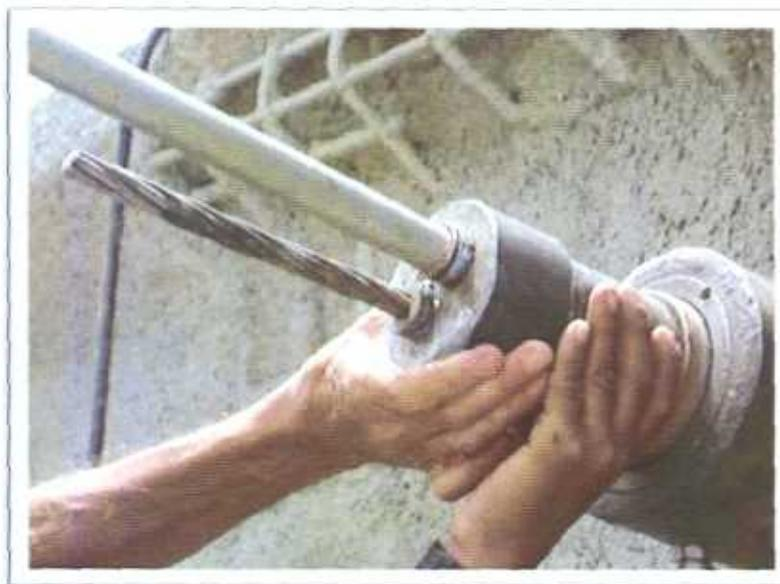
Anexo N° 13.2 Imagen representativa que muestra la colocación del cabezal y cuñas de tensado.
