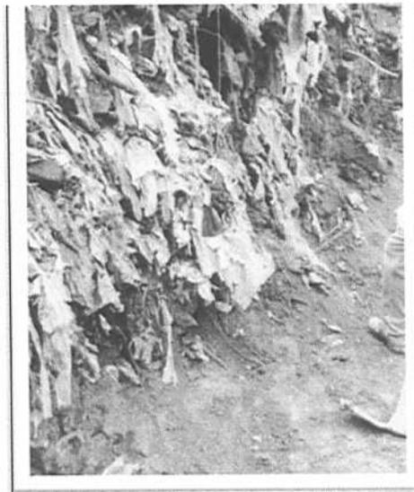
Anexo N° 4.2 Imagen representativa de terreno contaminado que deberá removerse antes de la construcción de una pantalla.
