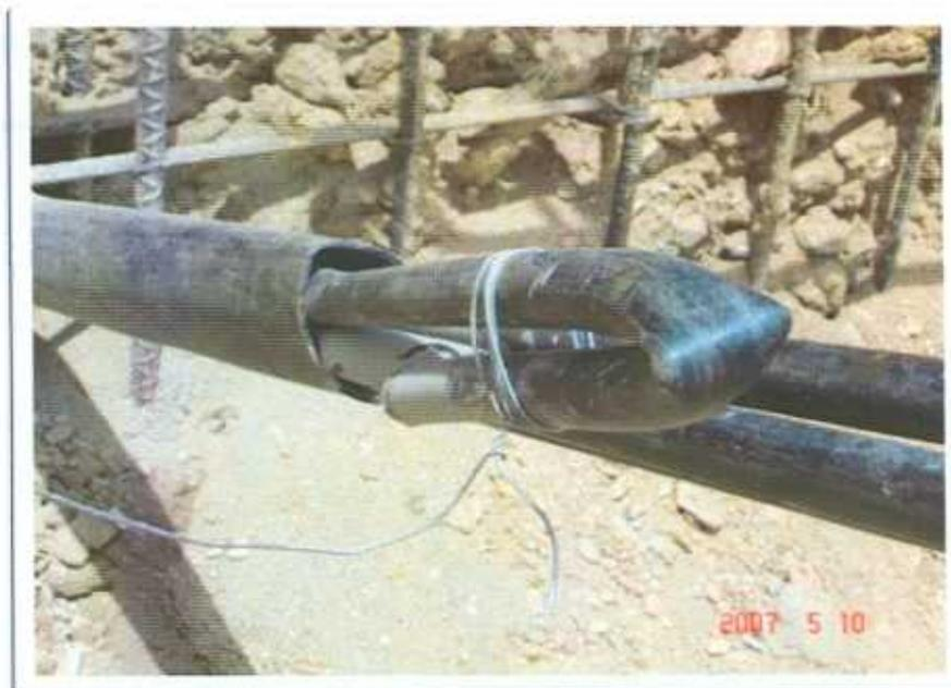
Anexo N° 12.3 Imagen representativa que muestra el sellado del tubo de inyección.
