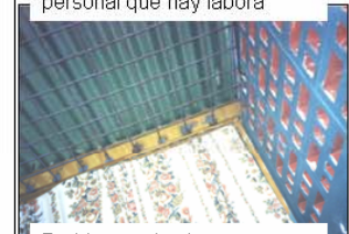
Problemas de altas temperaturas a causa de alturas muy bajas de 2.50 y del uso inapropiado del material que cubre el techo.
