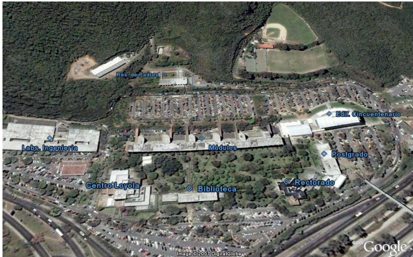
FIGURA 6. VISTA AÉREA DE LA UNIVERSIDAD CATÓLICA ANDRÉS BELLO. FUENTE: SOFTWARE DE NAVEGACIÓN GOOGLE EARTH. DICIEMBRE 2006.
