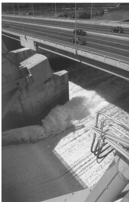
Puente vial aguas abajo del Aliviadero y Casa de Máquinas N° 2 y 3. Fuente: CVG EDELCA
