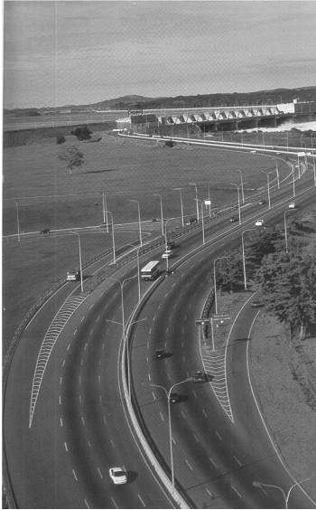
Central Hidroeléctrica Antonio José de Sucre, Macagua En primer plano vialidad Leopoldo Sucre Figarella - Pedro Palacios Herrera. Fuente: CVG EDELCA.
