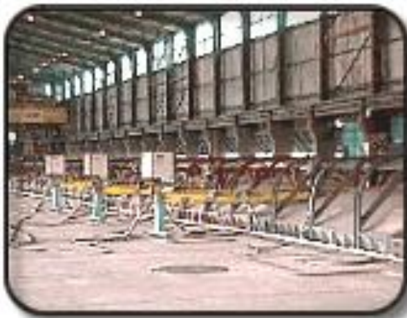
Figura 3 – 5. Vista de las secciones de los hornos
