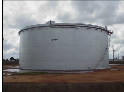
Figura 4.- Tanques de almacenamiento
