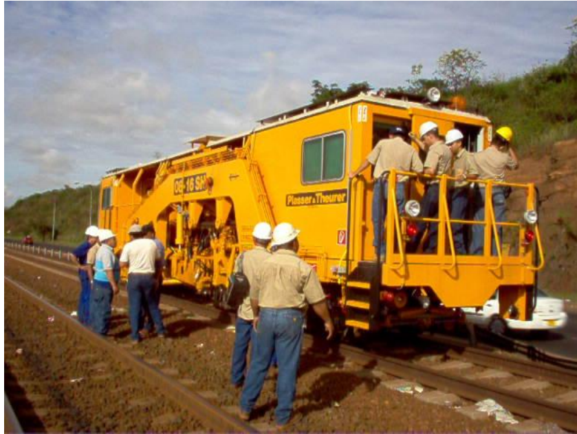
Fig. N° 11 Vías Férreas Tipo C de la CVG-Ferrominera del Orinoco.
