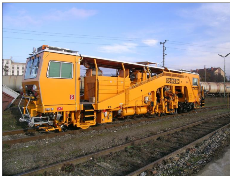
Figura N° 10, Equipo Split Head en desplazamiento en la vía Férra.
