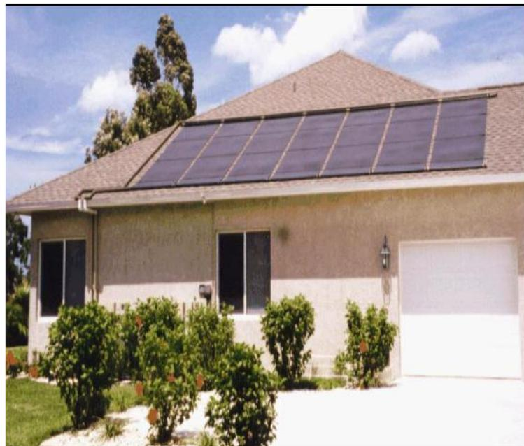
**Fig. 8 Calentador solar para piscinas, modelo de techo**
