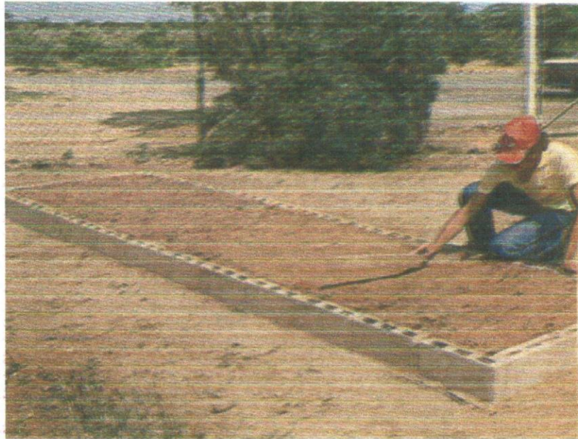
Foto 22: Cantero de una sola hilada construido con bloques.
