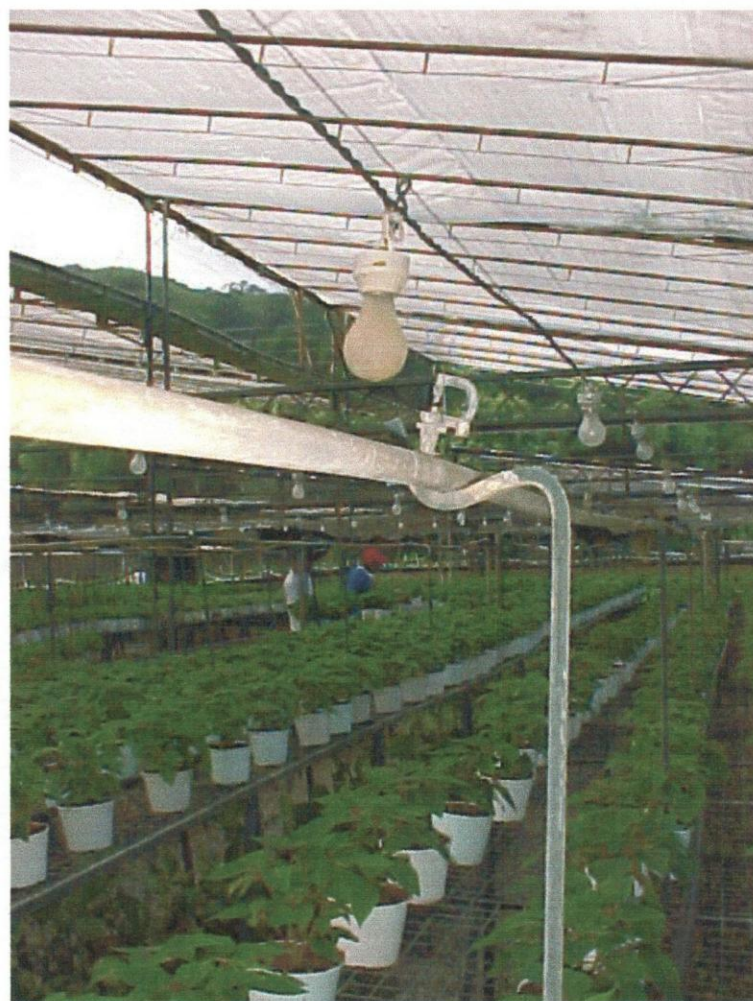
Foto 1: Agropecuaria Girasol: detalle del techo a un agua y del sistema de riego por nebulización.
