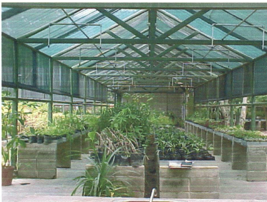
Foto 10: Vivero Didáctico del Parque del Este "Rómulo Betancourt" vista: general del umbráculo, detalle del techo a dos aguas y de las cortinas laterales.
