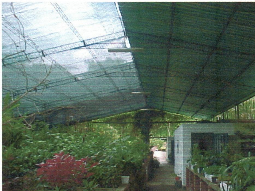
Foto 21: Vivero del Jardín Botánico de Caracas: vista general del techo a un agua construido con dos materiales, acerolí y malla.
