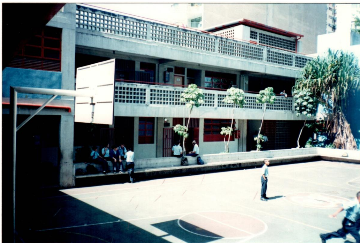
Vista parcial de la Cancha y del Edificio N° 3
