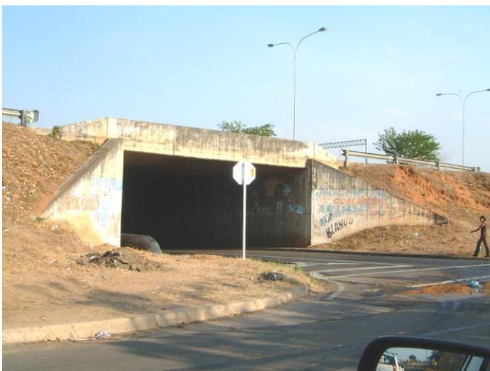
El Contratista debió realizar por orden de EDELCA la construcción de la nueva aducción para San Félix, en sustitución de la línea afectada por la autopista y la construcción del cajón vial de la progresiva 1+770.
