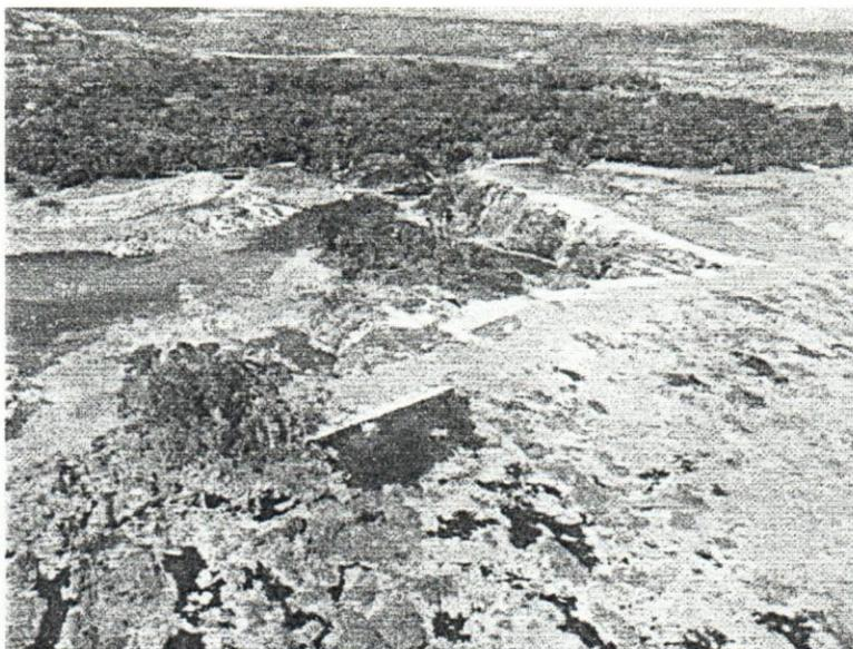
Durante los trabajos se removieron 95.000m<sup>3</sup> de enrocado desde el canal de encauzamiento y del canal de descarga del salto. Se reparó y protegió el contacto roca-concreto de la fundación del muro que separa el canal de descarga del aliviadero y de la Casa de Máquinas No. 3 el cual había sido erosionado. Para ello se dispusieron de 1.650m<sup>3</sup> de concreto y 25.000 Kg. de acero para refuerzos y anclajes.
