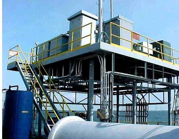
**Fig. 8** Plataforma eléctrica de una instalación en el lago de Maracaibo, en la cual se observan los rectificadores
